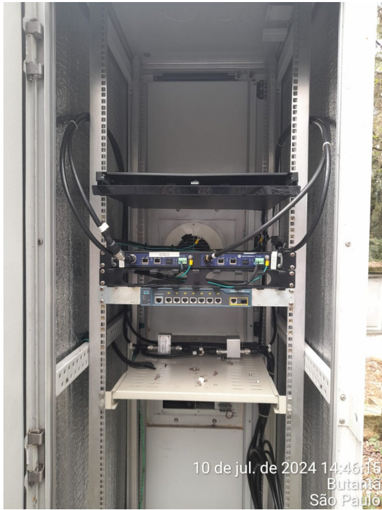
Rádio à ser desinstalado
